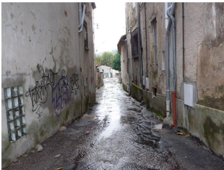
Une rue du Vigan après les événements de 2014 – photo SIVU Ganges le Vigan
